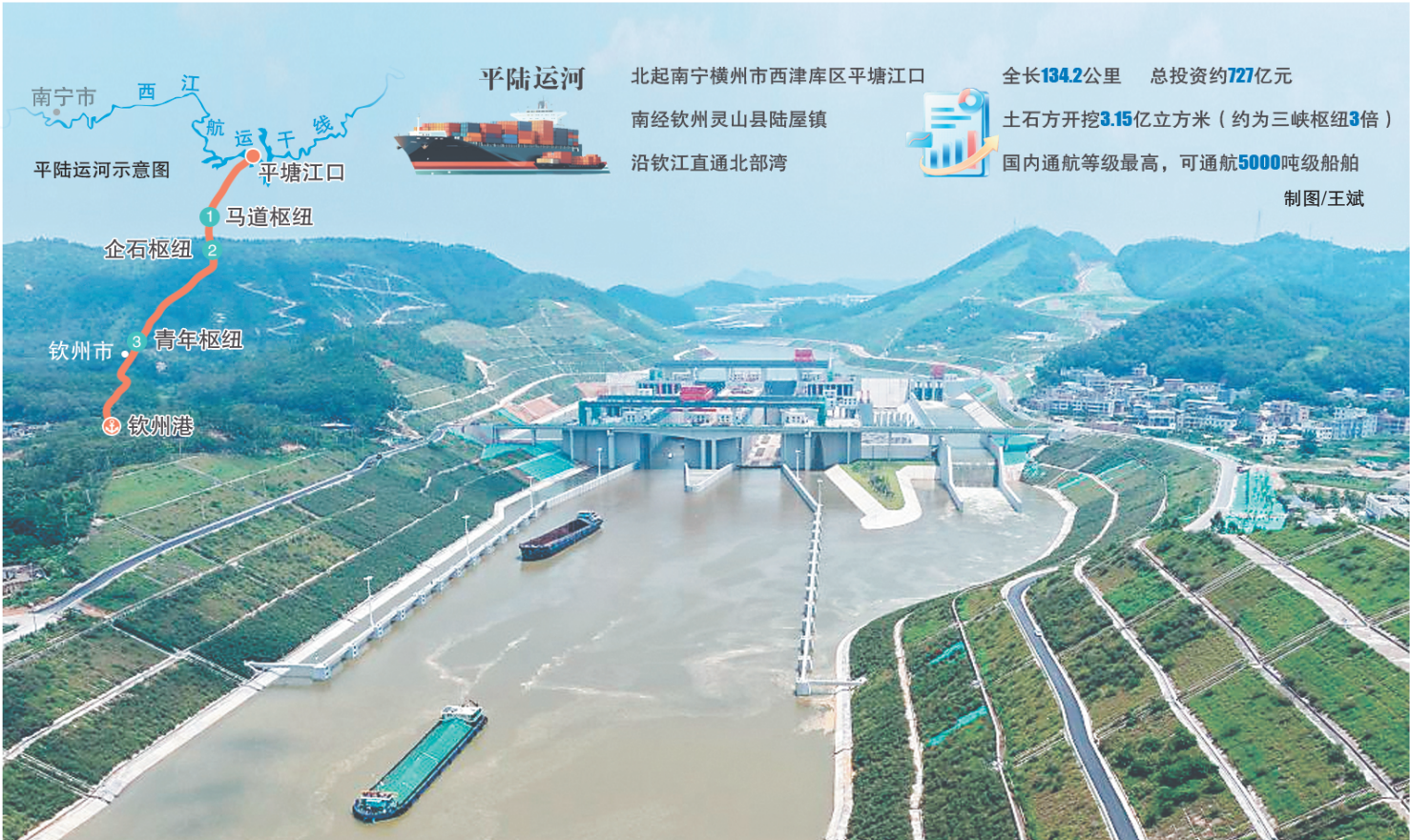
9月16日,新中国成立以来第一条国家层面统筹建设的通江达海运河工程——平陆运河建成通航,开辟西南出海新通道。这是平陆运河马道枢纽船闸(无人机照片)。
